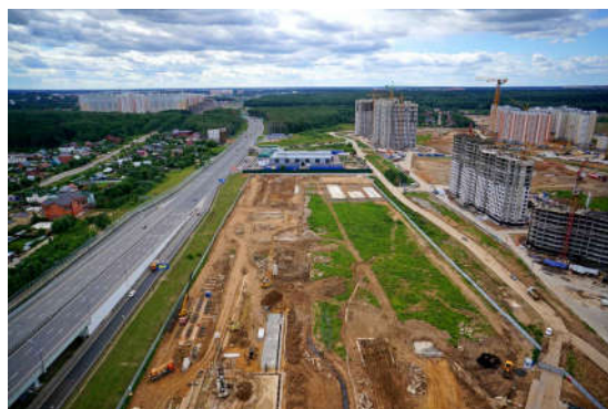
Công trường thi công nút giao “Raskazovka”
